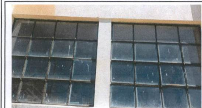
Foto1: Se puede observar que las ventanas están al descubierto y se priorizará balcones, puesto que se teme que entren a las aulas, se pondrán balcones en esta área.
